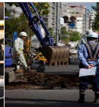
SUPERVISIONE IN CANTIERE
